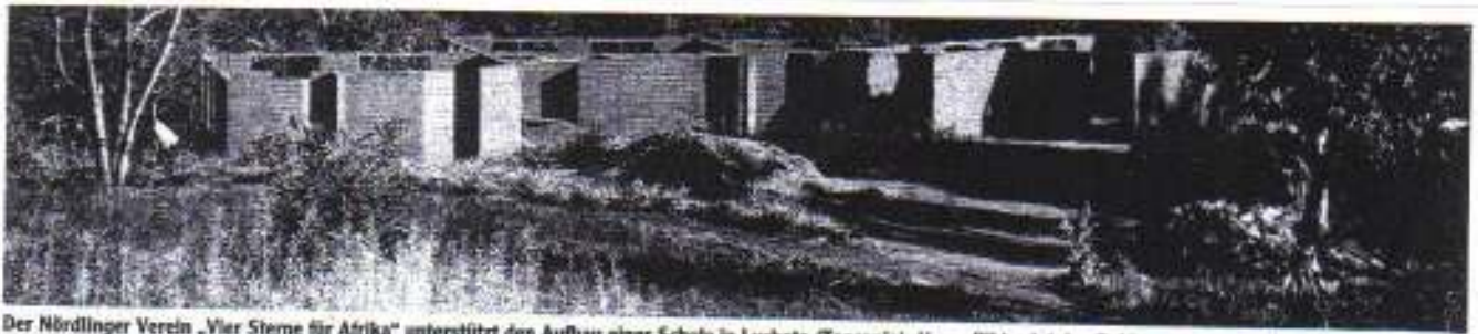
Der Nördlinger Verein „Vier Sterne für Afrika“ unterstützt den Aufbau einer Schule in Lushoto (Tansania). Unser Bild zeigt den Rohbau der Einrichtung. Fotos: priv
